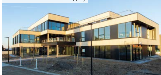
La Pilaterie – Villeneuve-d'Ascq (59)
